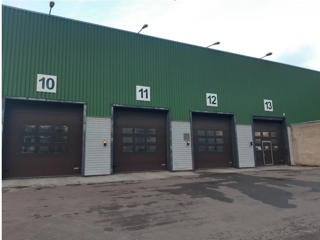
Foto 2 (Peterburi tee 73, Tallinn remonditöökoja ukсед)
