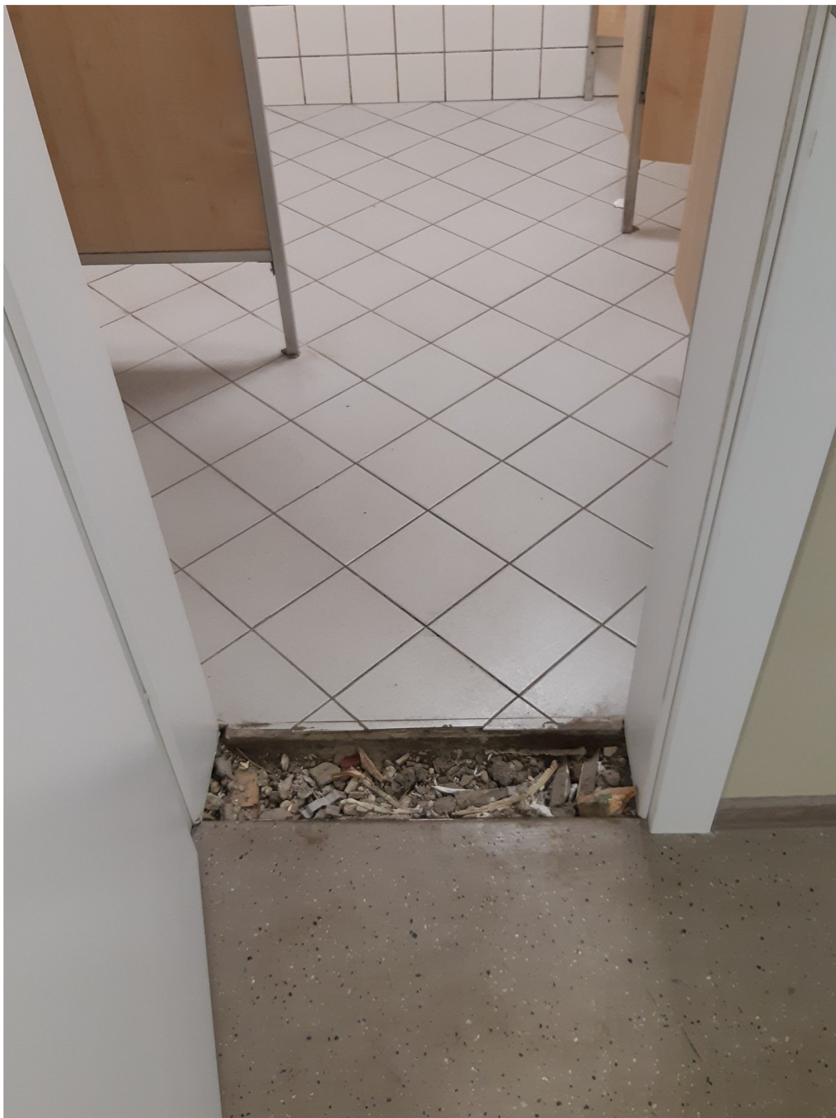
Foto nr 10 üks neljast lävepakust, mis on vaja paigaldada ja viimistleda
