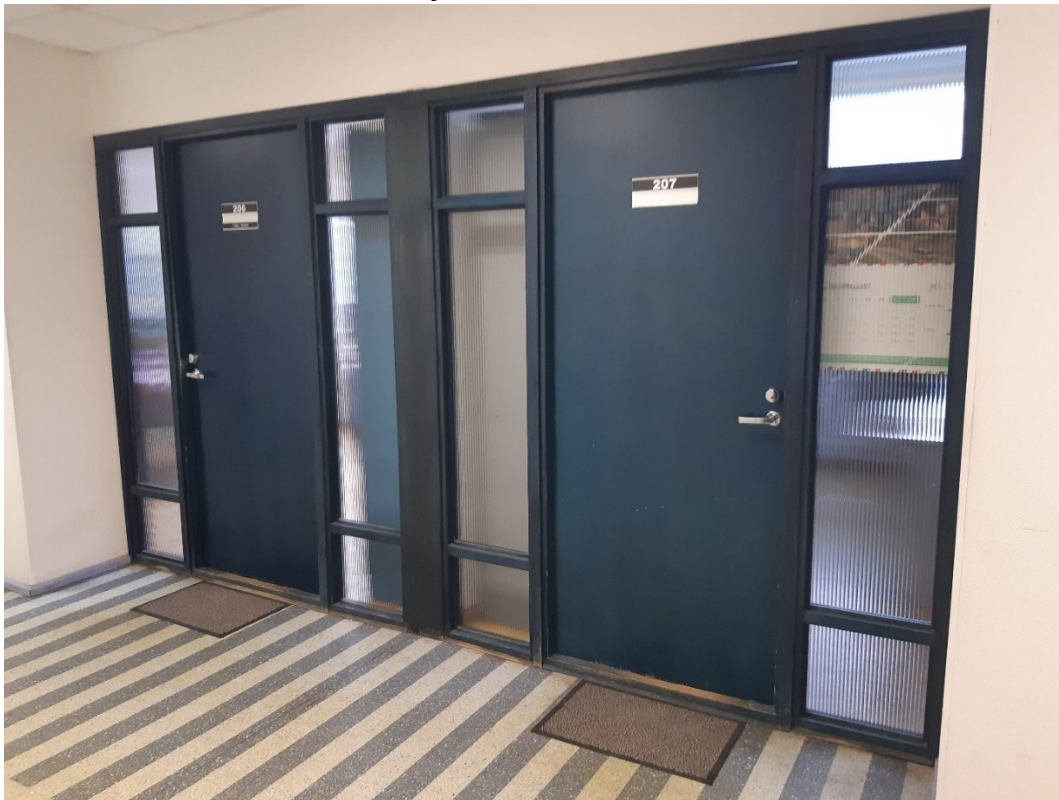
Foto nr 4 admin.tiiva koridor (vahetamisele kuuluv tuletõkkeuks ja likvideerimisele kuuluv väike aken koos aknalauaga)
