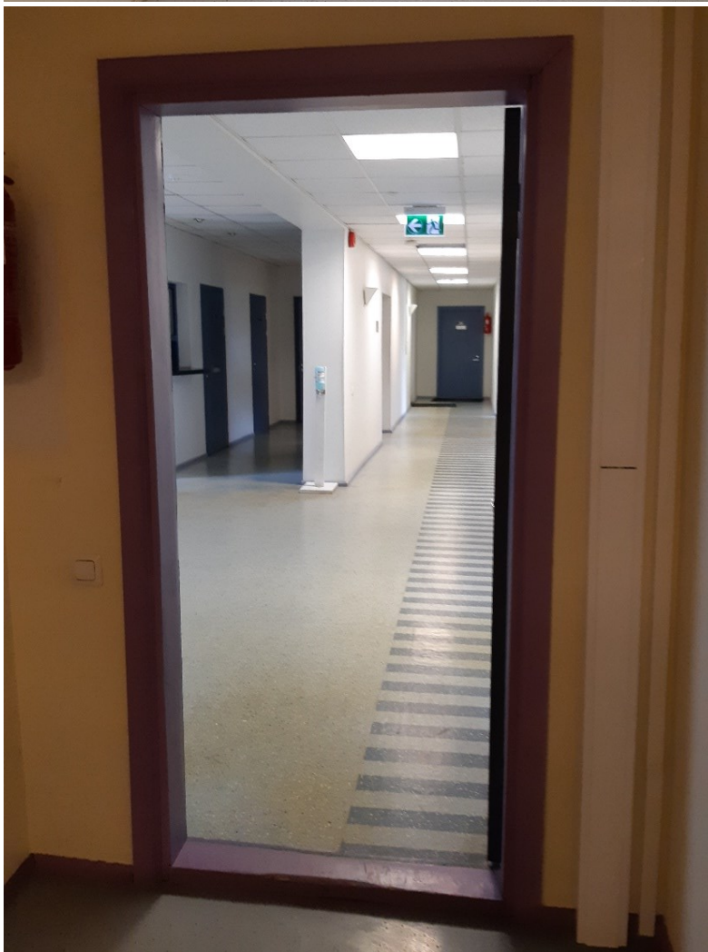
Foto nr 7, likvideerimisele kuuluv siseuks ja ukseava laiendamine
