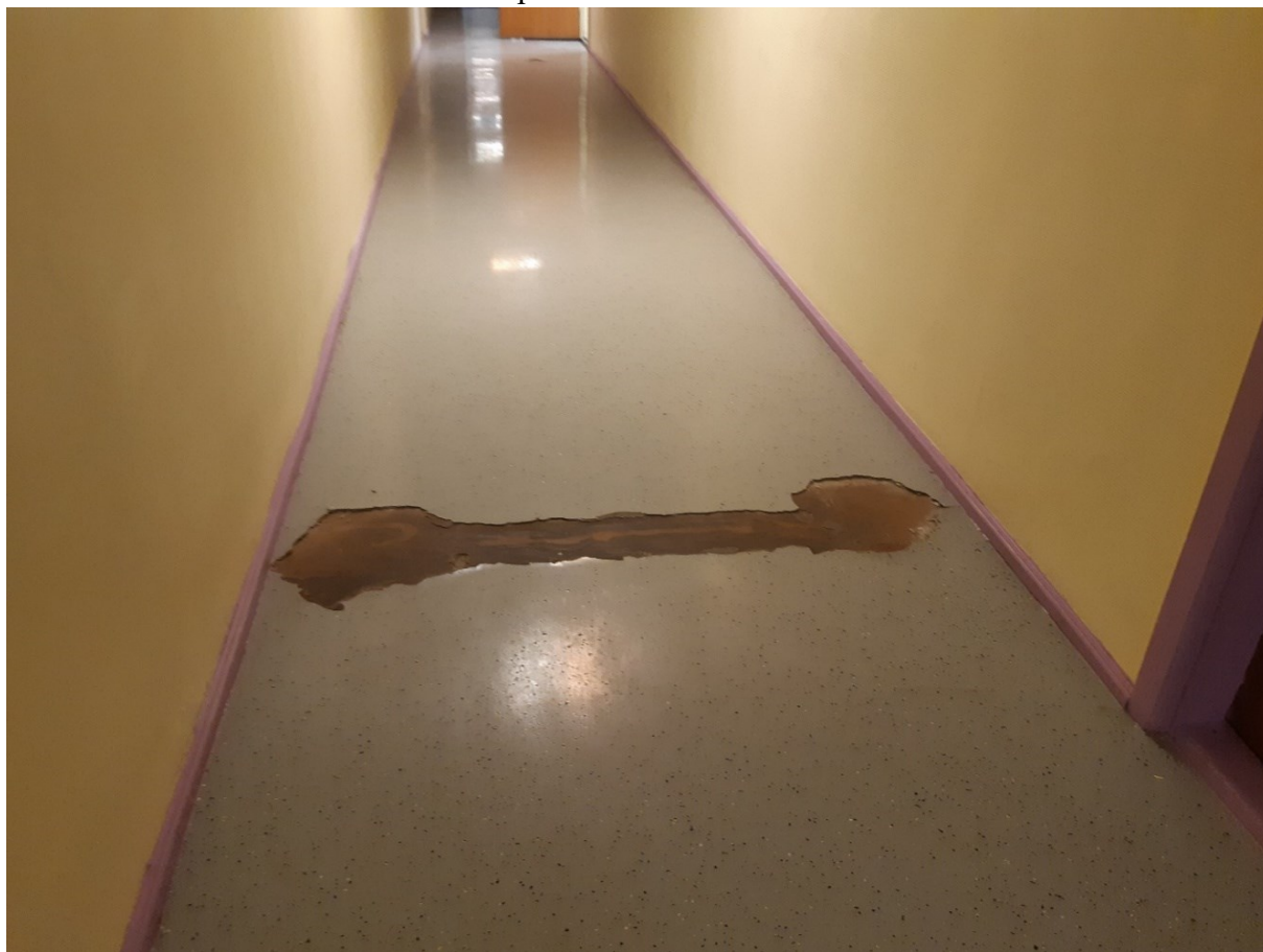
Foto nr 5 admin.tiiva osaline koridori põrand
