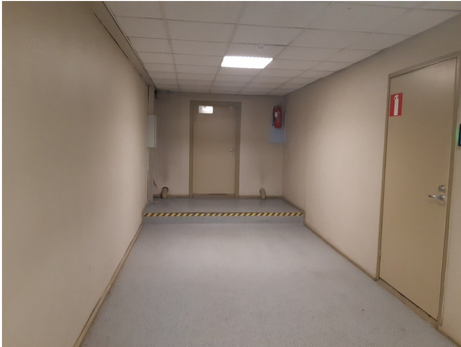
Foto nr 6 olmetiiva koridor (pildil olevad ukseid kuuluvad väljavahetamisele)
