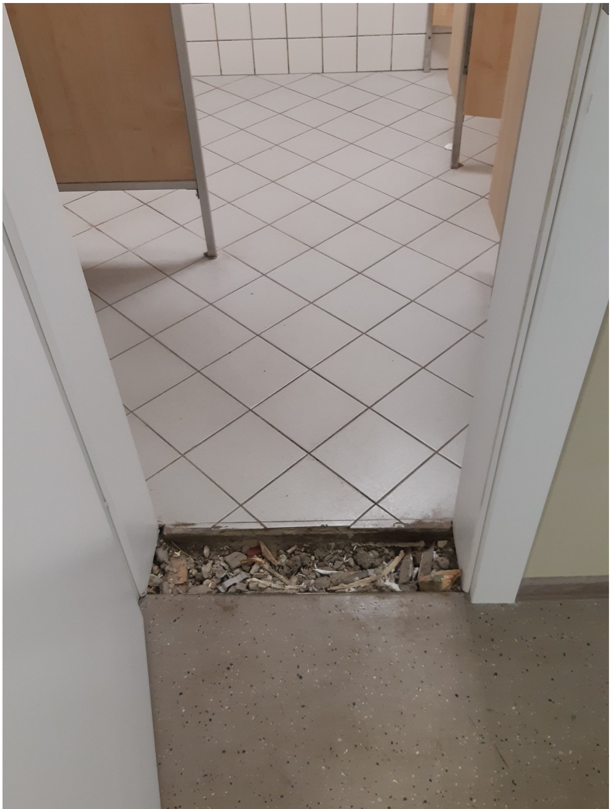
Foto nr 10 üks neljast uksepiidast, mis on vaja paigaldada ja viimistleda
