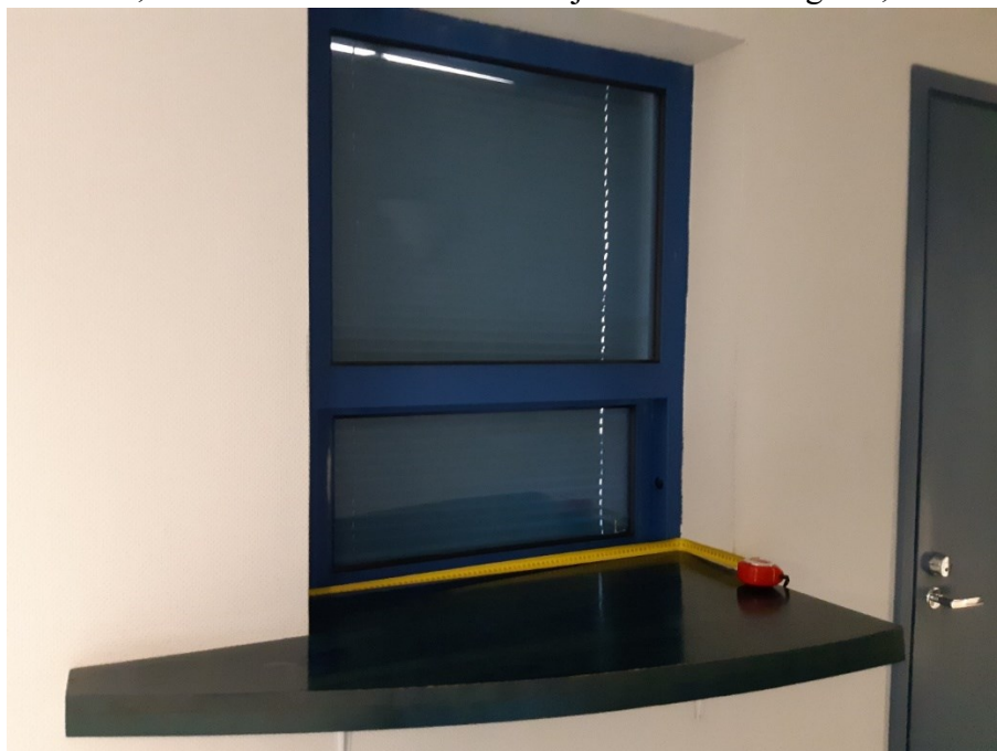
Foto nr 8, likvideerimisele kuuluv aken ja akanalaud ning ava, mis on vaja kinni ehitada
