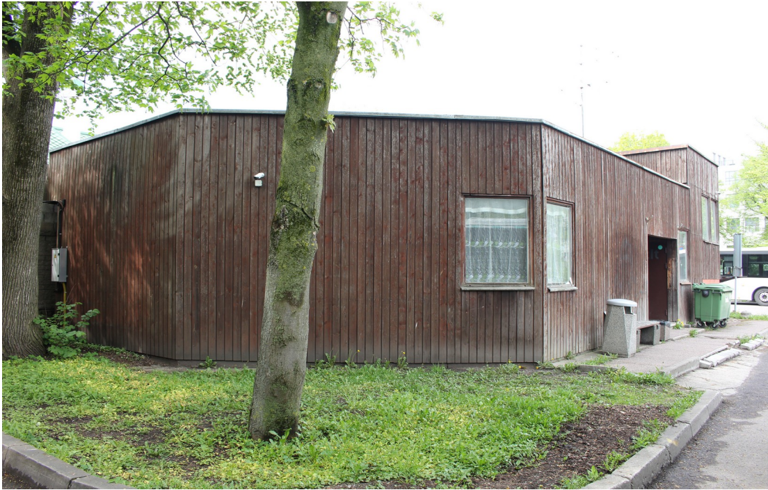
Foto nr.1. Vaade lammutatavast hoonest Rannamäe tee poolt
