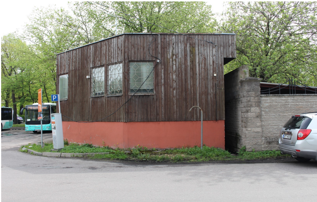
Foto nr.2. Vaade lammutatavast hoonest trammitee poolt.
