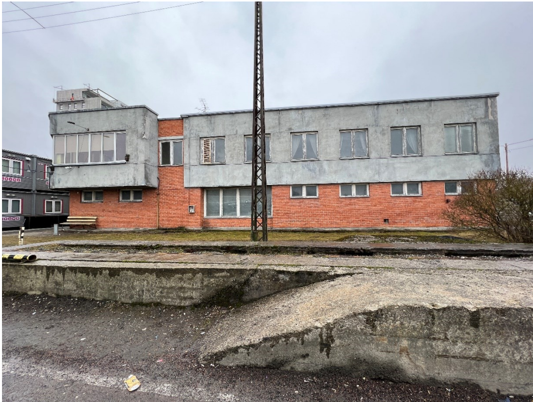
Pilt 3: lammutatav hoone, 1. vaade
