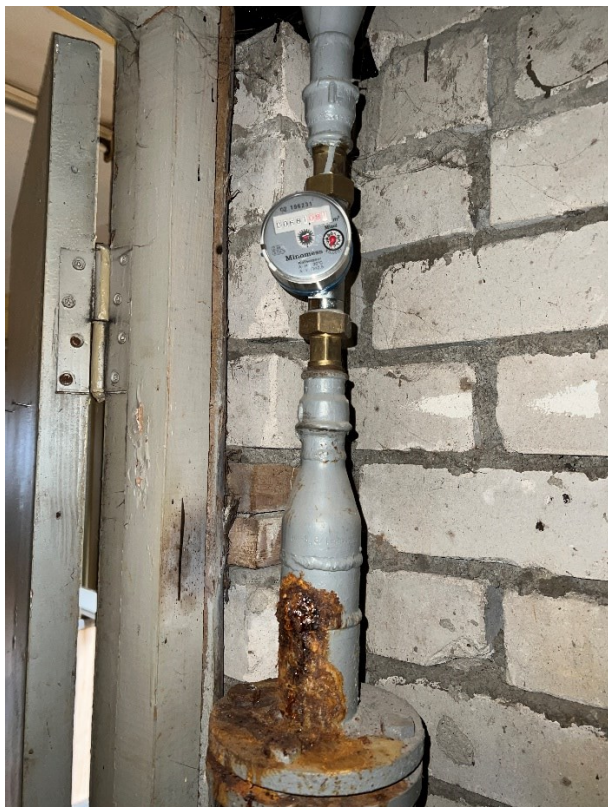
Pilt 11: olemasolev veemõõdusõlm hoones.
