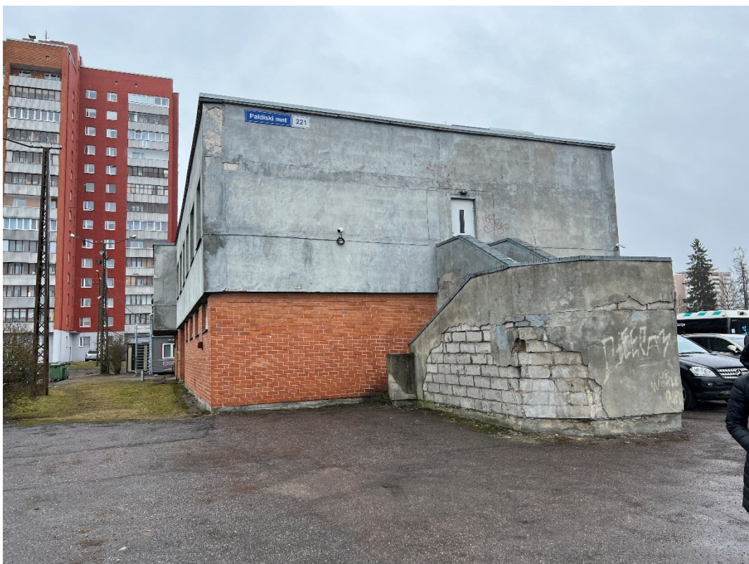
Pilt 4: lammutatav hoone, 2. vaade
