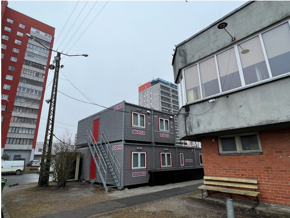
Pilt 12: olmesoojakud lammutatava hoone juures, hoonega ühenduses olev pingestatud elektrikaabel.
