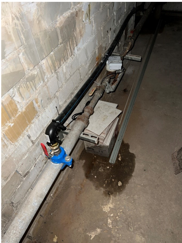
Pilt 11: olemasolev veemõõdusõlm hoones.
