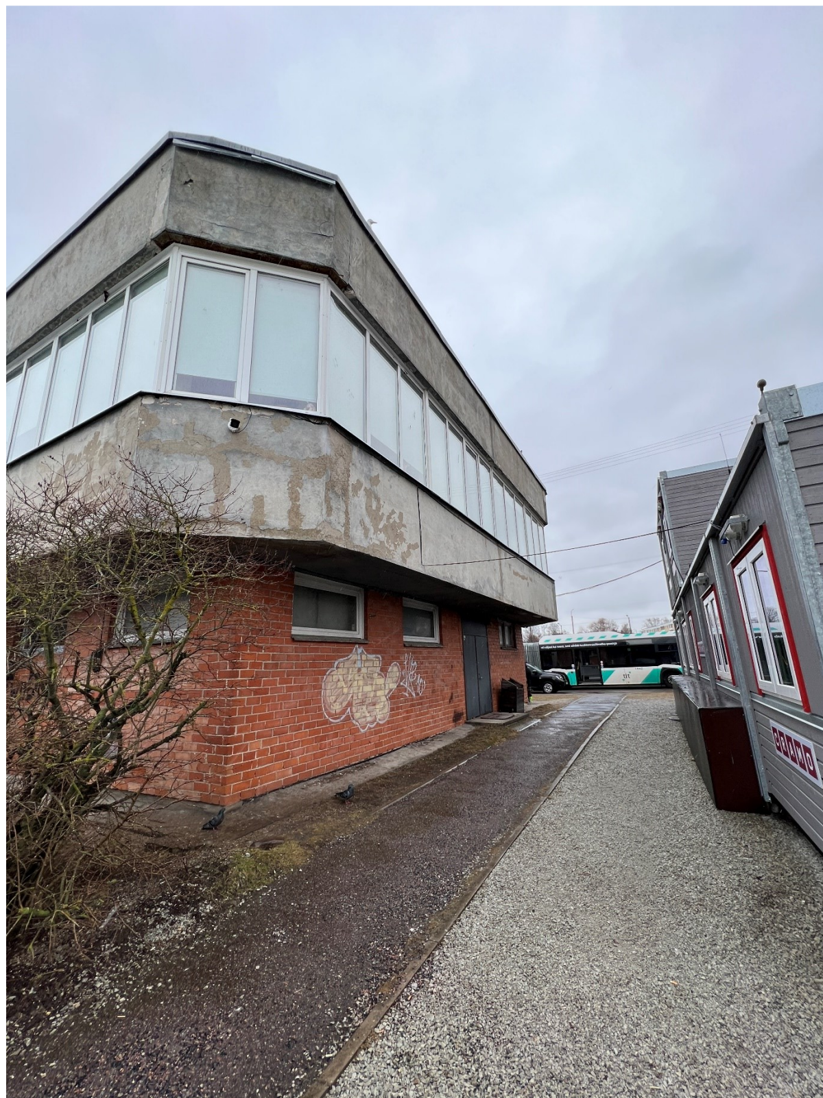
Pilt 7: lammutatav hoone, 4. vaade.
