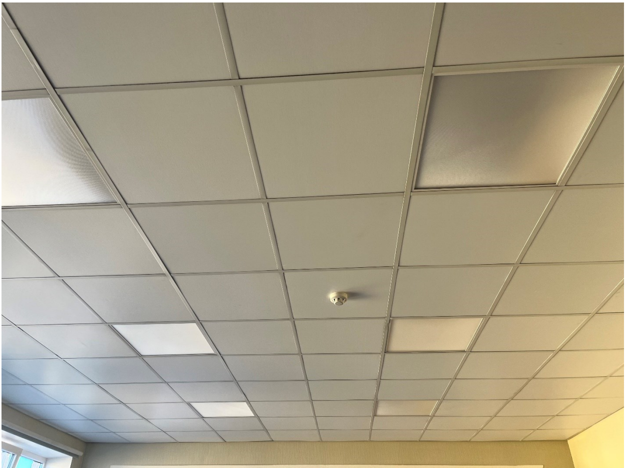
Õppeklassi olemasolev lagi ja laevalgustid. Laeplaadid demonteerida ja utiliseerida.
