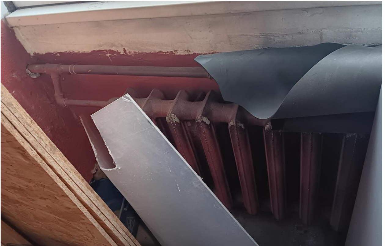
Foto nr 5: hoones asuvad ka vanad malmradiaatorid ja metalltorustik, mis tuleb nõuetekohaselt utiliseerida ja küttesüsteem rekonstrueerida.
